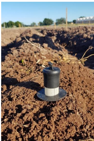
Figura 9. Instalación de tubos de acceso
